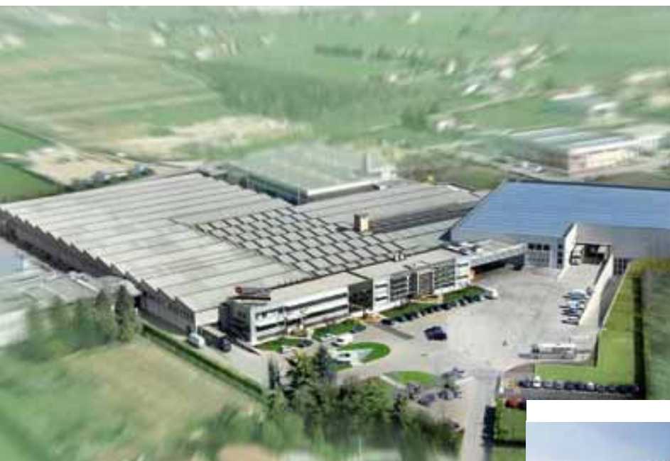
Stabilimento La Nordica Montecchio Precalcino
