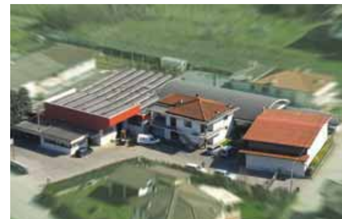
Training Center La Nordica-Extraflame Montecchio Precalcino
